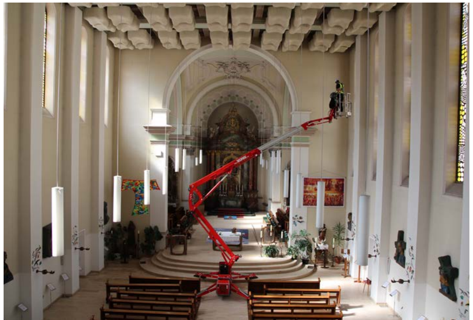
Arbeiten bei geringen Platzverhältnissen
